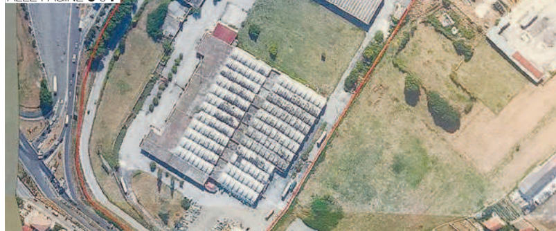
Una veduta dall'alto dell'area ex Permafex di Frosinone, oggetto di riqualificazione
